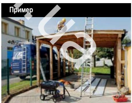
Вы хотите обеспечить питанием шлифмашина мощностью 1400 Вт. Вам нужен электроагрегат мощностью 3000 Вт.
